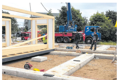
Auf dem FH-Campus wurden Container aufgestellt. FOTO: HOLLINDE
